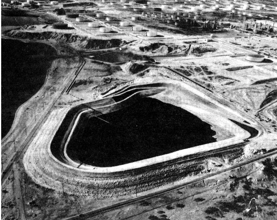
Figura 1: Estrutura de contenção e armazenamento de óleo combustível em barragem de terra - Creole Petroleum Corporation .
