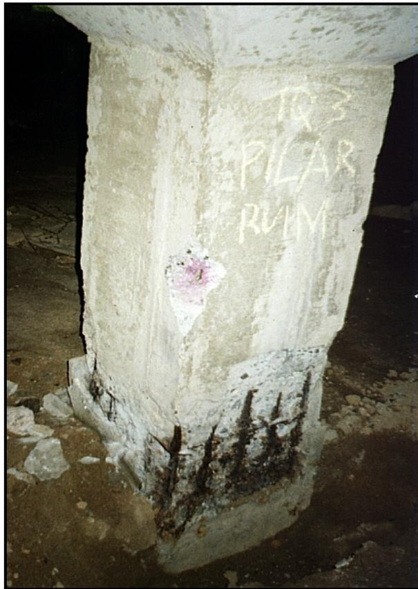
**Figura 13: Aspecto típico de deterioração nos pilares.**
